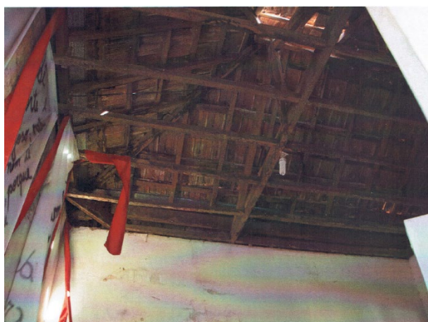
Figura 4 – Imagem vista interna cobertura Ourinhos-SP
